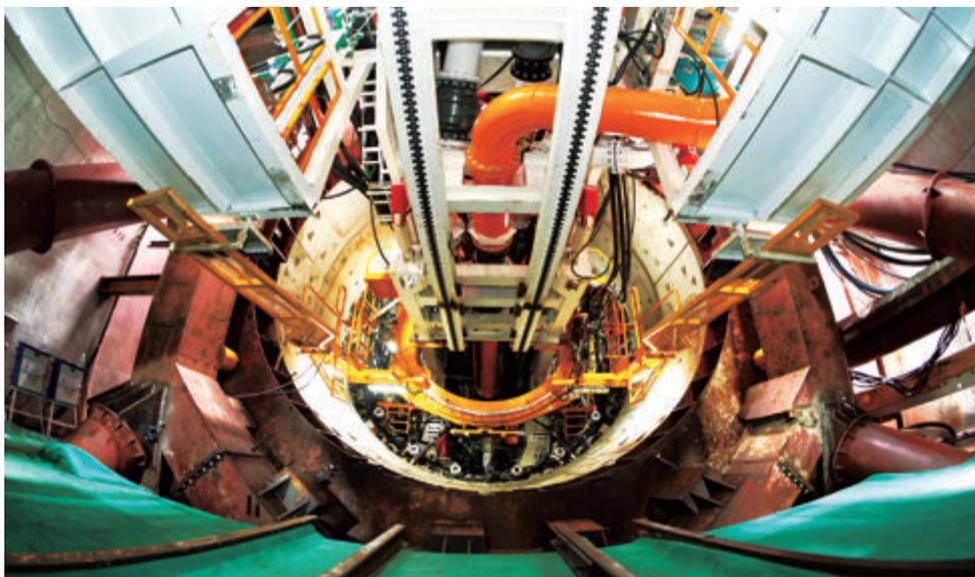
厦门电力与清水进岛隧道土建工程海域段盾构始发。
