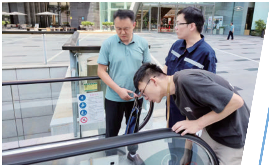
■技术人员检查扶梯使用情况。
