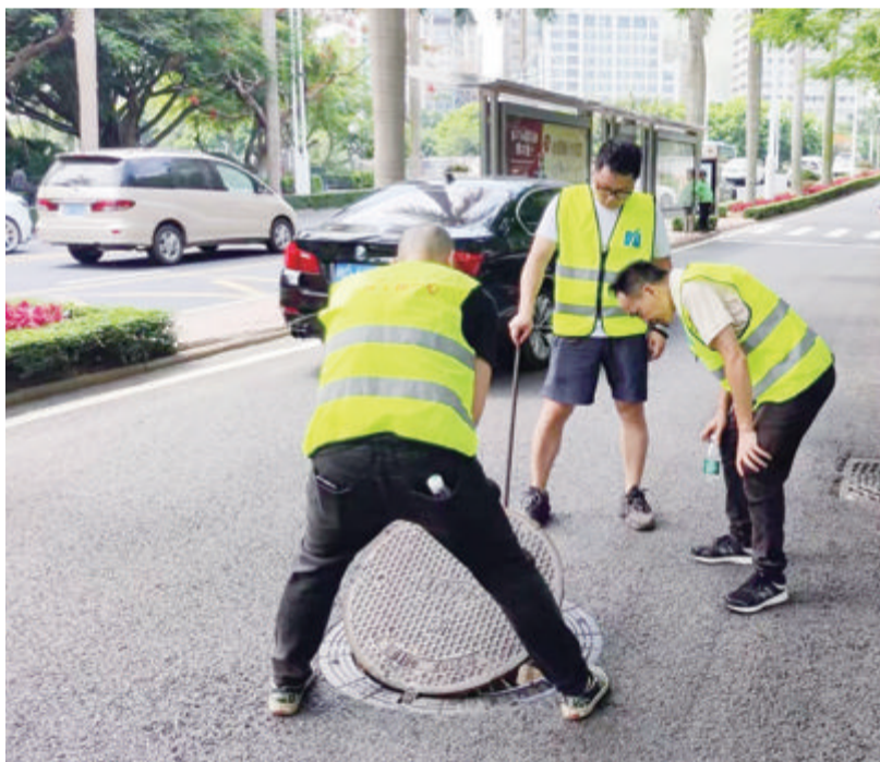
工作人员开展窞井盖专项检查。
