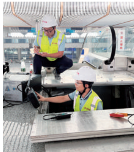
■工作人员正在对电梯进行检验。
