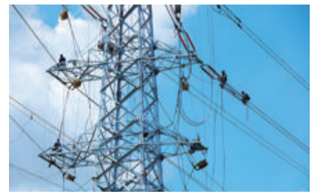
■施工人员高空作业现场。
