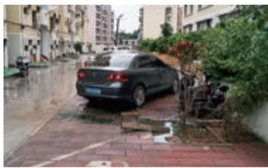
纺织路11-9号楼下,路面已铺好,边上却是污水横流。
