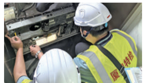
检测人员对电梯相关指标进行细致检测。
