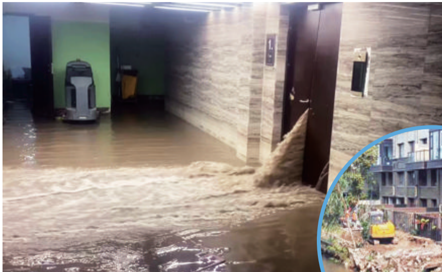
▲河水倒灌至小区地下车库。 ▶相关部门赶赴现场进行处置。
