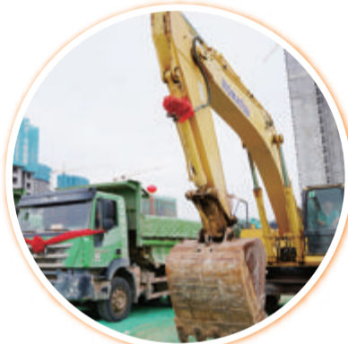
■厦门市第二外国语学校城南校区开工现场。 陈嘉新摄
