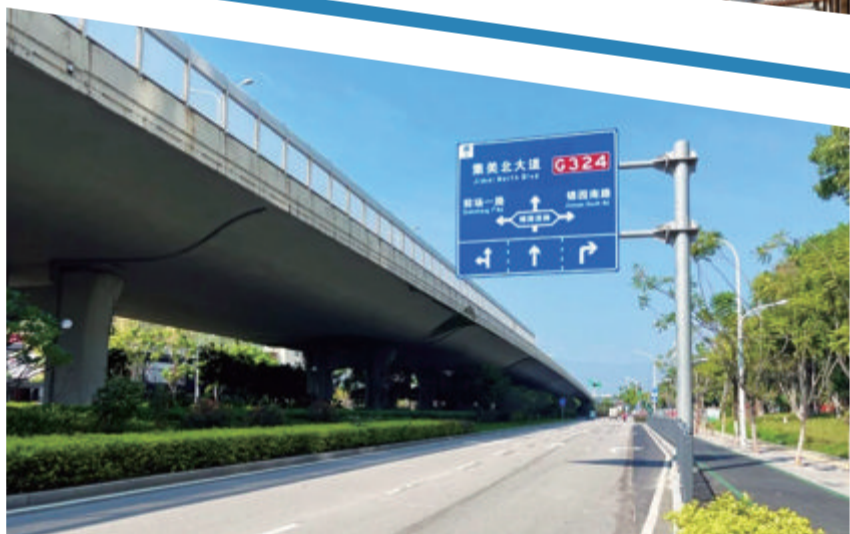
集美杏前路前场段拥堵点改造完成,出行更通畅。
